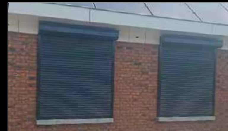
\ Installation contre le mur
